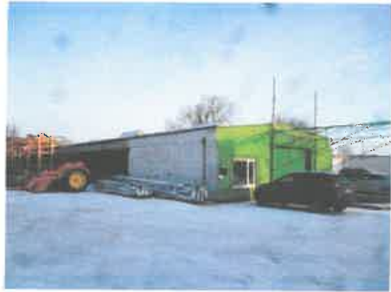
2 pav. Pastato 1F1b fasado fragmentas
