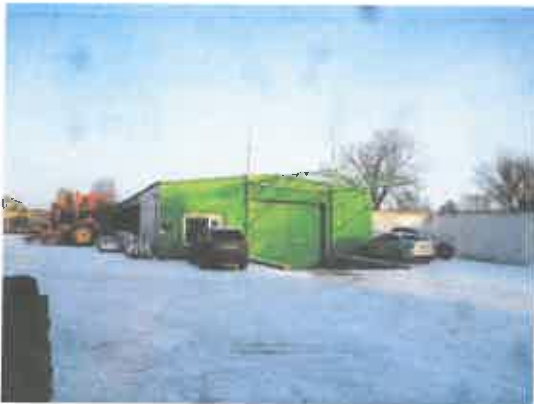
1 pav. Pastato 1F1b fasado fragmentas
