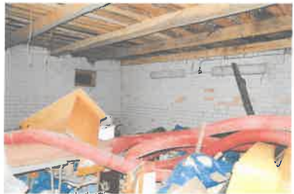
20 pav. Patalpa ūkio pastate
