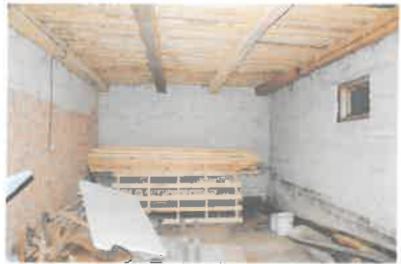
18 pav. Patalpa ūkio pastate
