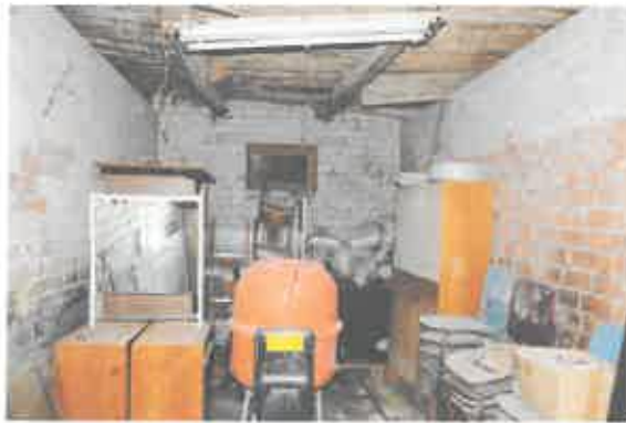
19 pav. Patalpa ūkio pastate
