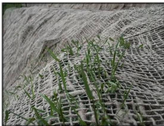
33 pav. Šlaitų apsauga pylimuose ir iškasose
