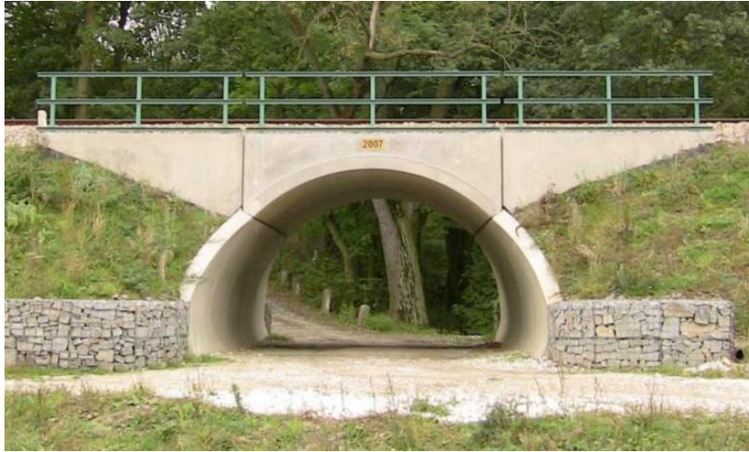
67 pav. Tiltas iš surenkamųjų elementų, naudojamas kaip požeminė perėja gyvūnams
