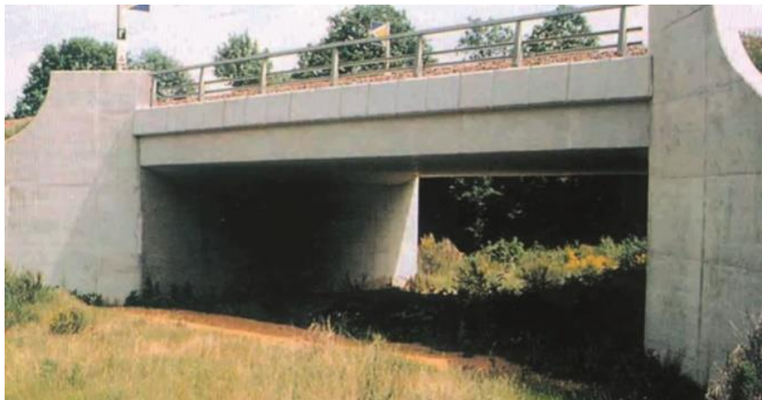
66 pav. Tiltas iš vietoje išliejamos betoninės struktūros, naudojamas kaip požeminė perėja gyvūnams
