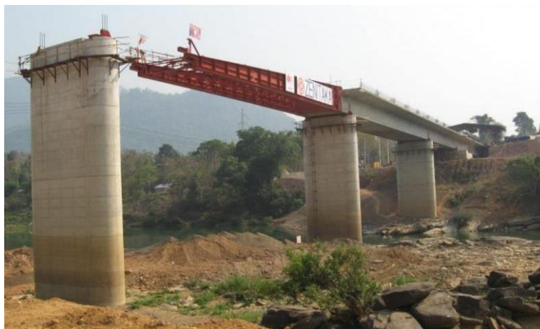
48 pav. Palaipsninio paleidimo metodas
