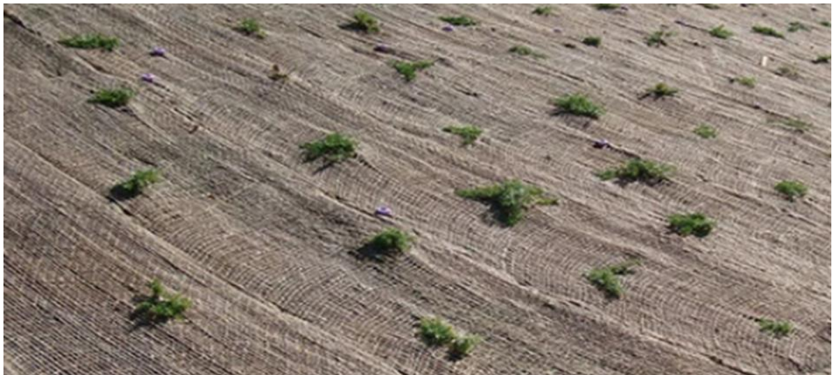
32 pav. Šlaitų apsauga biologiškai skaidžiais tinklais
