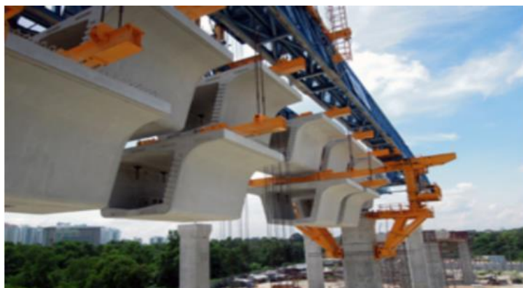
47 pav. Tarpatraminio tilto konstrukcijos etapas
