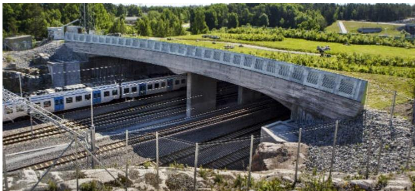
72 pav. Antžeminė perėja gyvūnams iš vietoje išliejamos betoninės struktūros
