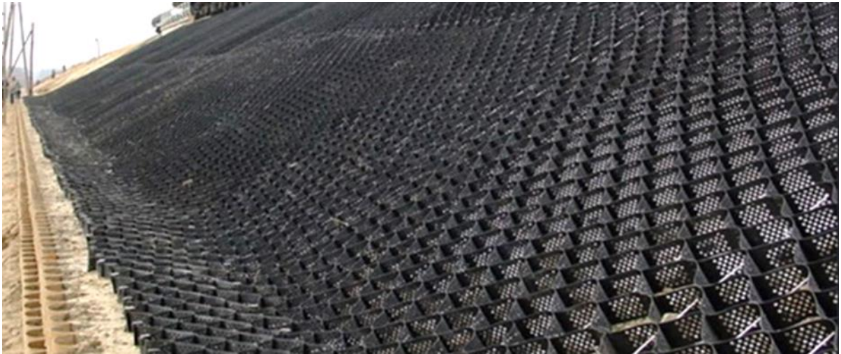
31 pav. Šlaitų apsauga su geokoriais
