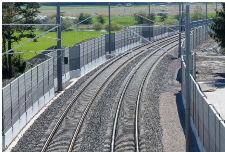
11 pav. Viršutinės kelio konstrukcijos pavyzdys
