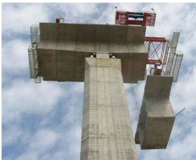
46 pav. Balansuotosios gembės surenkamosios statybos etapas
