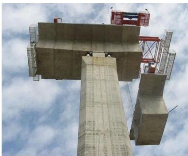
49 pav. Balansuotosios gembės surenkamosios statybos etapas
