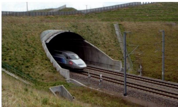
73 pav. Žalioji tiltas naudojant betonines struktūras iš surenkamų arkinių elementų
