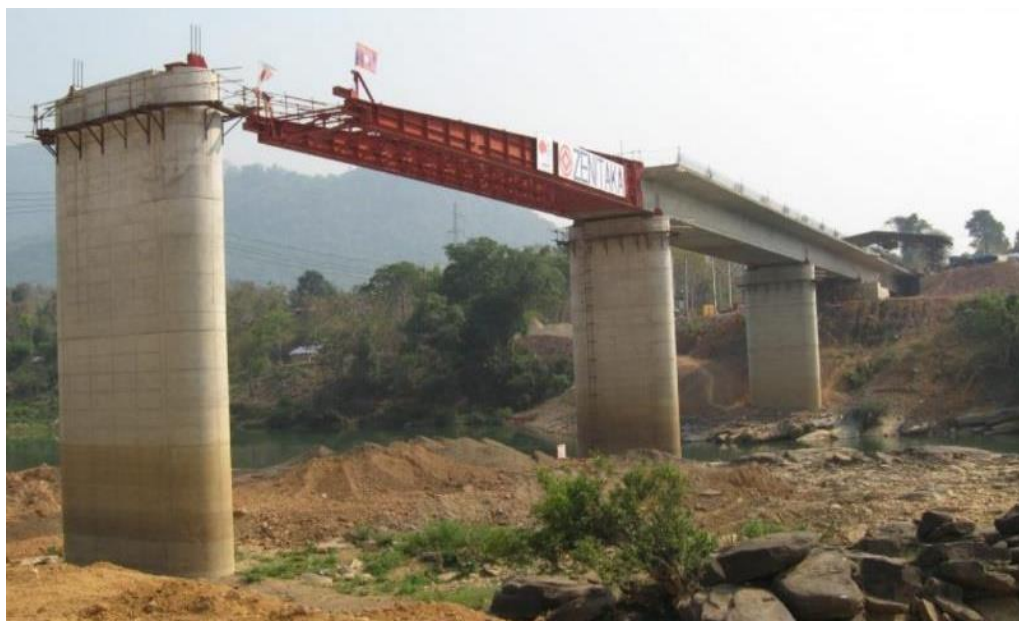
51 pav. Palaipsninio paleidimo metodas
