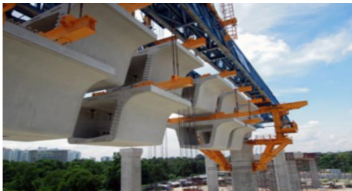
50 pav. Tarpatraminio tilto konstrukcijos etapas
