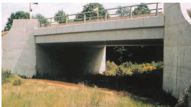
70 pav. Požeminė perėja gyvūnams po geležinkeliu iš vietoje išliejamos betoninės struktūros
